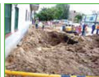
Trabajos de perforación y obra pública.
