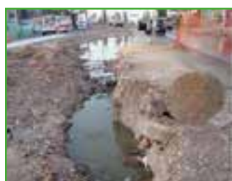
Tareas en el alcantarillado público.
