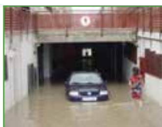
Inundaciones en bajos y garajes.
